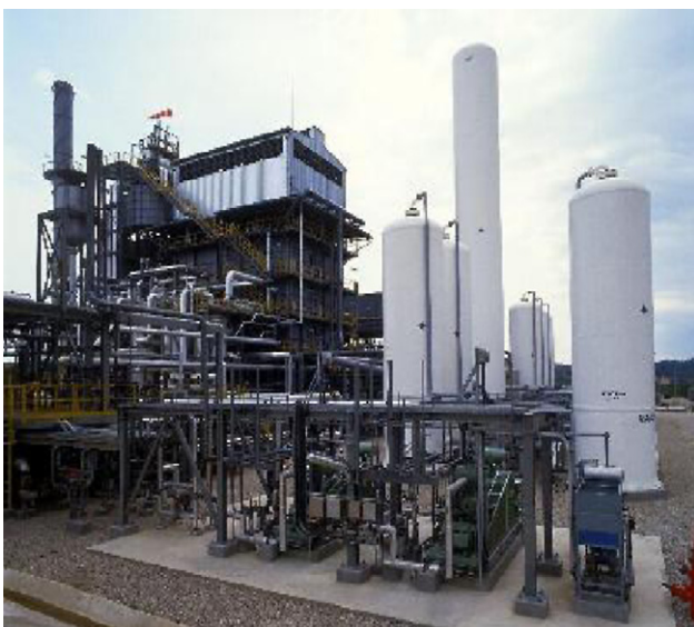
Fig. 2. Carbueros Metálicos SMR Plant in Tarragona.
